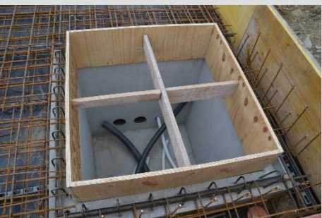
Bauseitige Holzschalung auf Höhe erstellen. Auf Wunsch wird diese von der Fa. Hieber mitgeliefert
