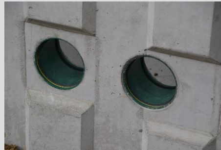
Rohranschluss säubern. Grundleitung mittels Gleitmittel versehen und anschließen. Mindeinstecktiefe beachten
