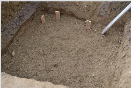
Aushub der Grube
