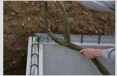
Versetzschlaufe im Schacht eindrehen und anhängen (2x Versetzschlaufen RD20 notwendig)
