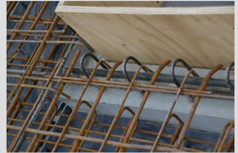
Arbeitsraum fachgerecht verfüllen und anschließend Bewehrung verlegen
