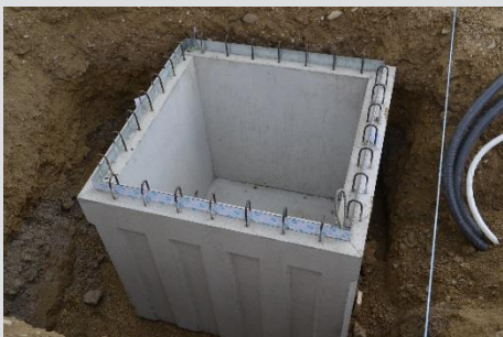
Setzen und Einmessen des Pumpensumpfschachtes
