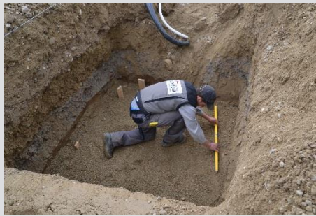
Einbau der Sauberkeitsschicht
