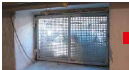
Vor der Sanierung
