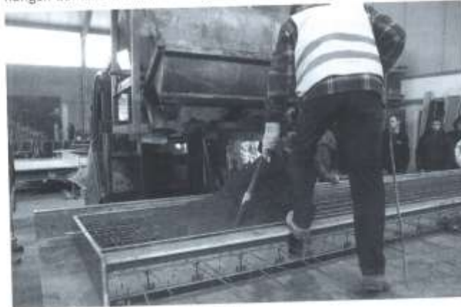
Herstellen eines Balkons aus rotem Beton
