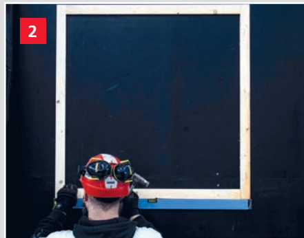
2 Stützrahmen auf richtiger Höhe waag- und senkrecht fixieren.
