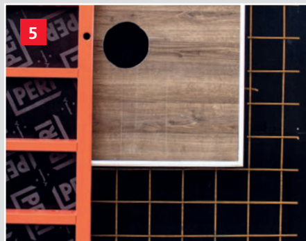
5 Nach dem Zuschalen ist der Rahmen von innen zusätzlich gegen Auftrieb zu sichern.
