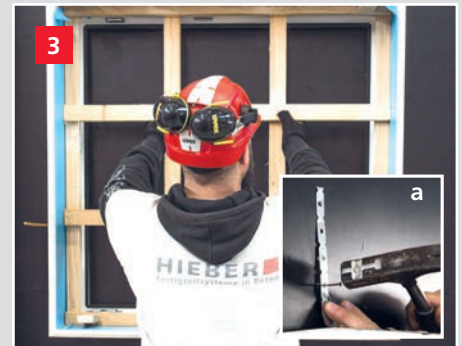
3 Kellerfenster IsolaMENT 3 auf befestigten Stützrahmen stecken. Anschließend Fenster gegen Absturz sichern (Abb. a) – nur Nageln, nicht Spaxen.
