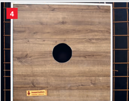
4 Aussteifungsplatte innen einsetzen.
