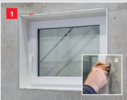
1 Vor Montage der Dämmschale muss die Wand auf Unebenheiten kontrolliert und evtl. nachgearbeitet werden. Öffnen der Kunststoffabdeckung (grauer Verschlussstopfen an Betonzarge siehe Abb. a).
