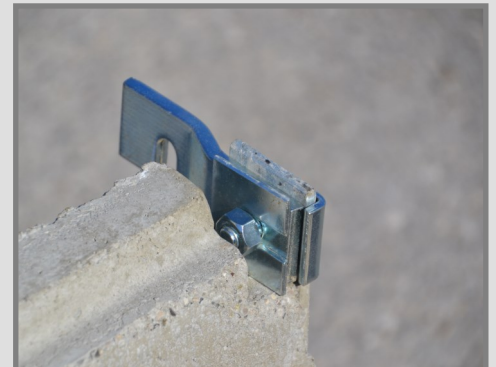
Verlängerungslaschen mittels 19er Maulschlüssel fest an Schacht anschrauben
