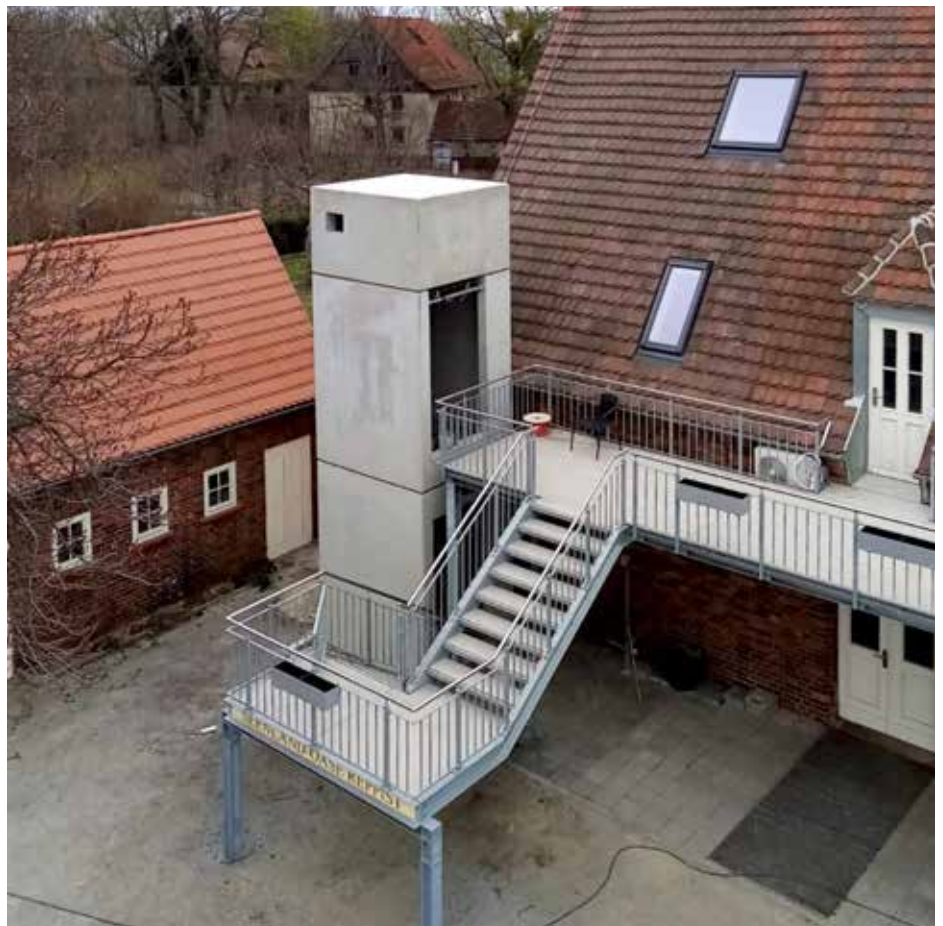
Aufzugschacht in Sichtbeton, Senftenberg.
