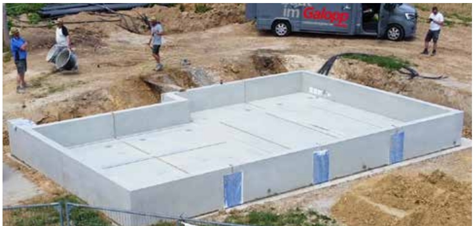
Fundamentbodenplatten für NIO Deutschland: Power Swap Stations Ulm-Seligweiler (Bilder), Geiselwind, Schipkau, Reiskirchen, Schkeuditz, Mühldorf am Inn
