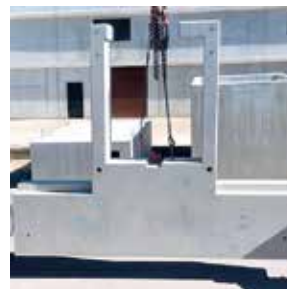
Auskragendes Podest für Treppenhaus
