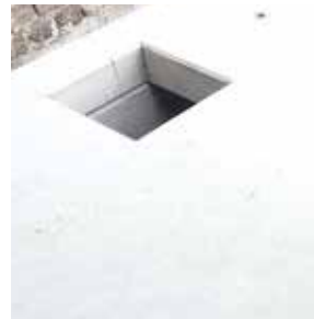
Entrauchungsöffnung im Deckel
