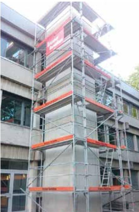
Vorgefertigte schlanke Betonelemente ermöglichen den schnellen und rationellen Bau von Aufzugsschächten. Bereits im Werk werden Halfenschienen, Gerüsthülsen und weitere Einbauteile entsprechend den Vorgaben des Aufzugsbauers eingebaut.
